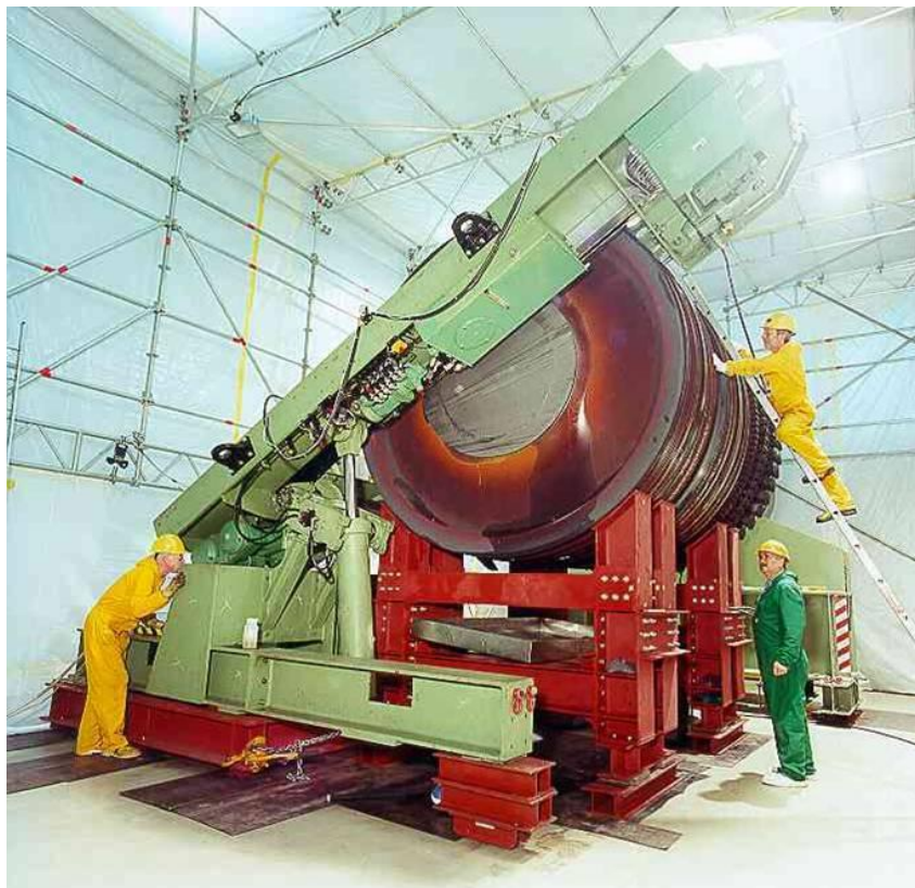
Abbildung 7: Zerlegen eines Turbinenläufers mit einer Bandsäge
