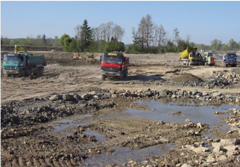
Herstellung des Gewässerbettes der neuen Iller vor der Flutung
