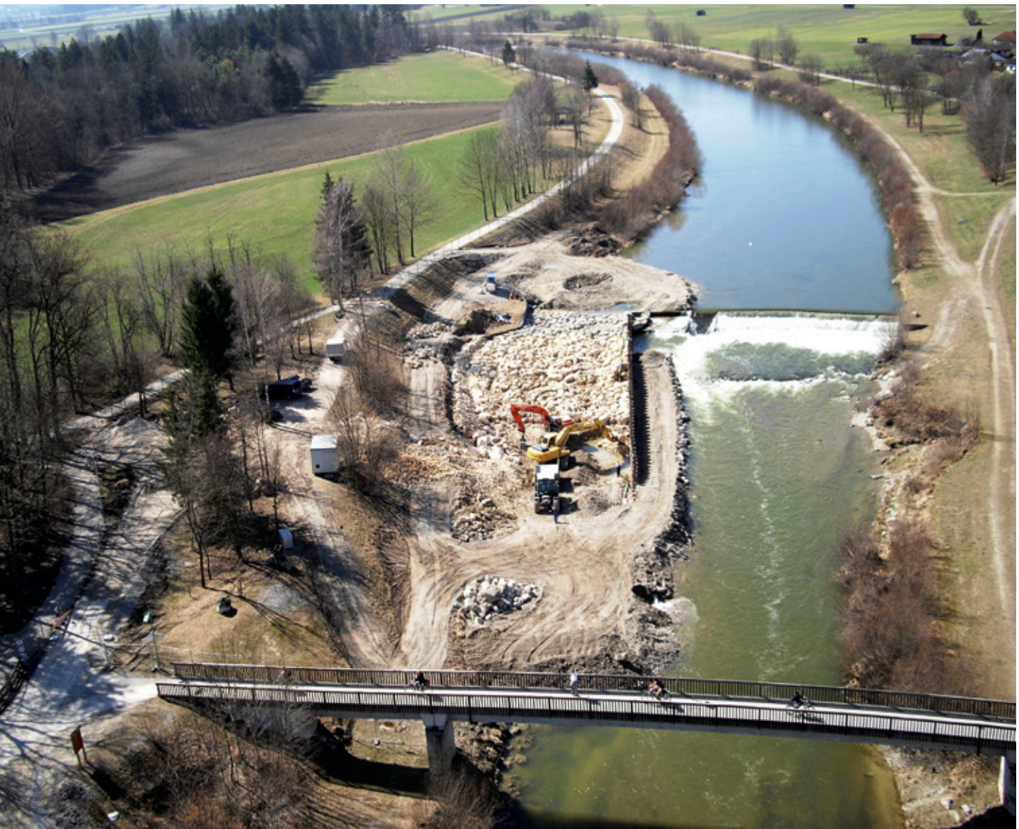
Baustelle aus der Vogelperspektive
