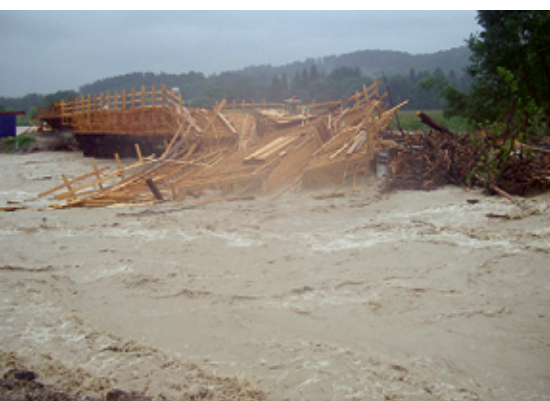
Einstürzendes Schalgerüst beim Augusthochwasser (Foto links: © Sonner)
