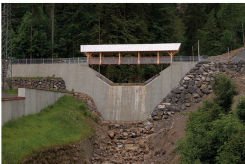
Konsolidierungssperre zur Stabilisierung eines Rutschhanges am Steigbach bei Immenstadt. Ausführung als Schwergewichtsmauer. (Foto: © T. Galleman LfU)
