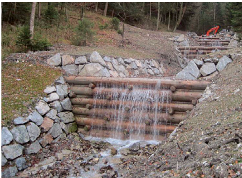
Sperrentreppe in Holzkastenbauweise zur Konsolidierung der Ufer des Stallauerbaches bei Bad Heilbrunn. (Foto: © P. Gröbl WWA Weilheim)
