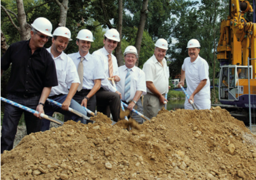
Spatenstich zu den Hochwasserschutzmaßnahmen mit der örtlichen Prominenz
