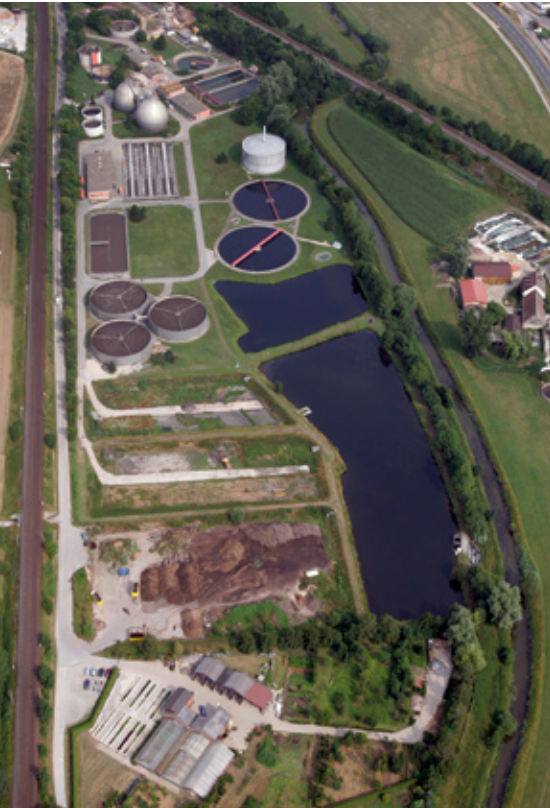
Kläranlage Ansbach (Foto: © T. Esch WWA Ansbach)
