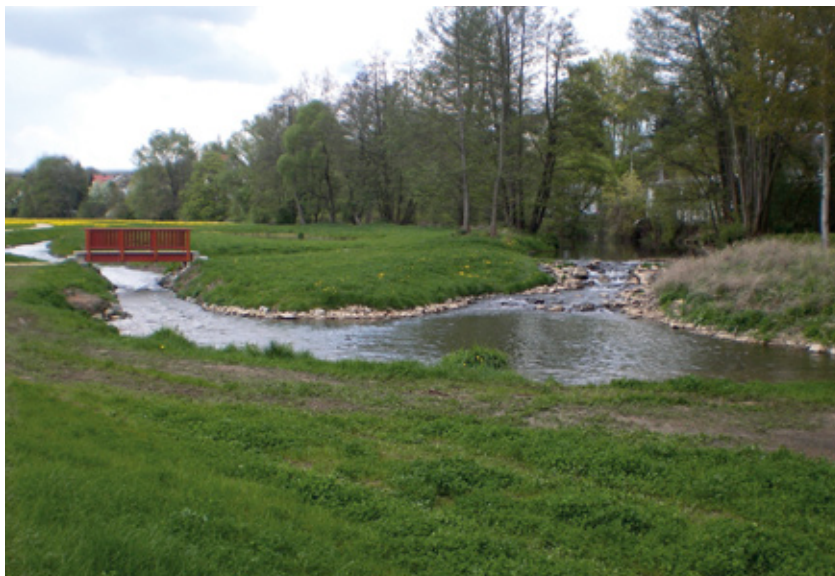
Das Umgehungsgewässer und die Rampe zum Oberwasser im Bereich des früheren Sägewerkes
