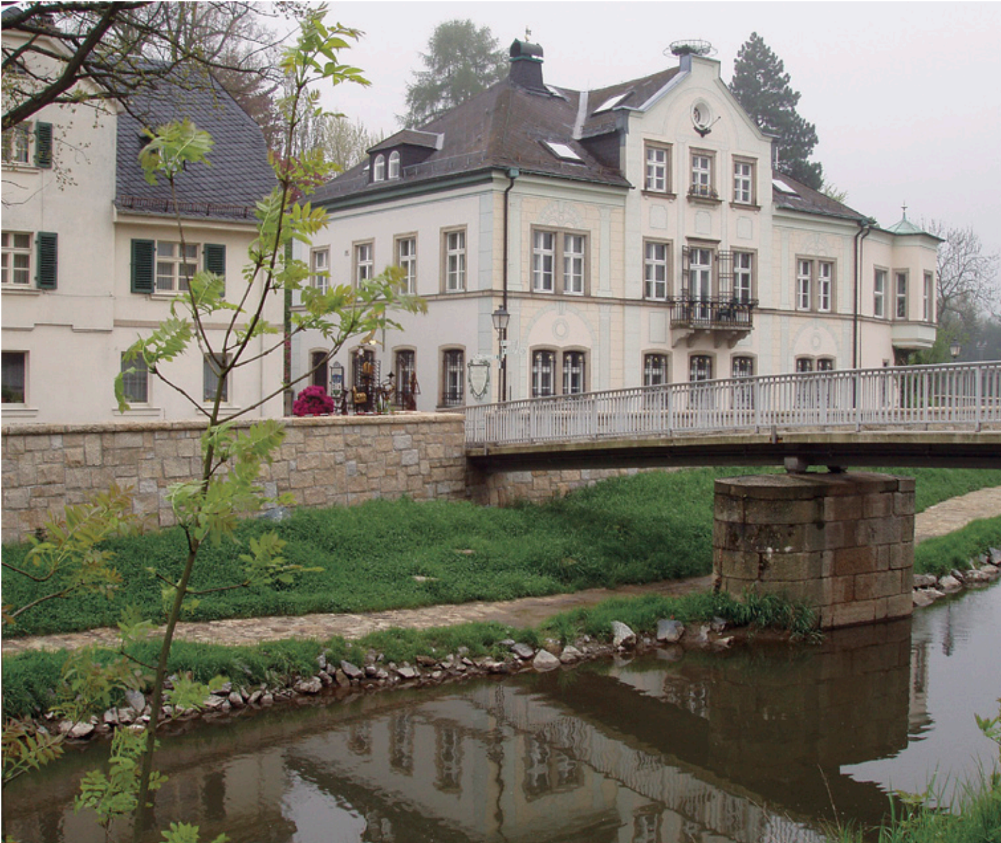
Hochwasserschutzmauer im Innenstadtbereich
