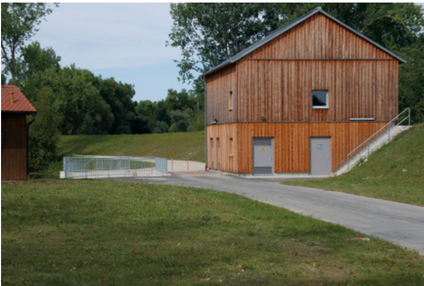
Neues Schöpfwerk mit Hochwasserschutzdeich
