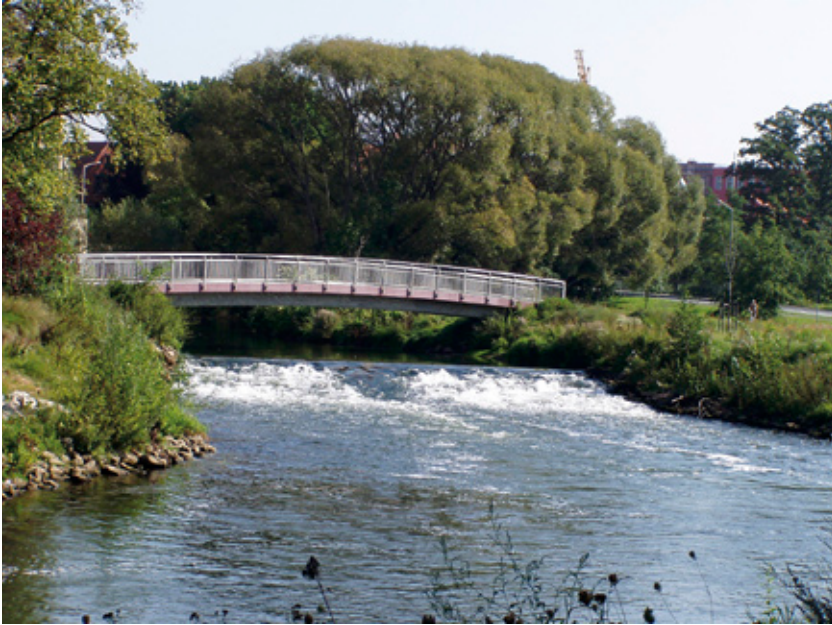
Durchgängigkeit für Mensch und Tier – neue Brücke und neue Sohlgleite
