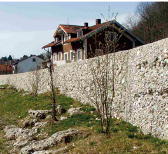
Oben links: Hochwasserschutzwand nach Fertigstellung
