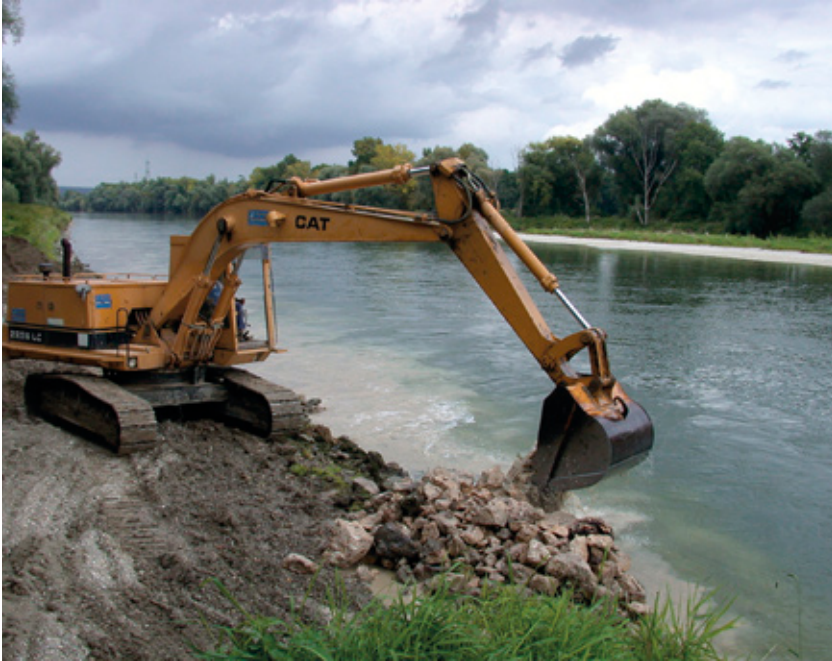
Entnahme der Uferversteinung zum Bühnenbau
