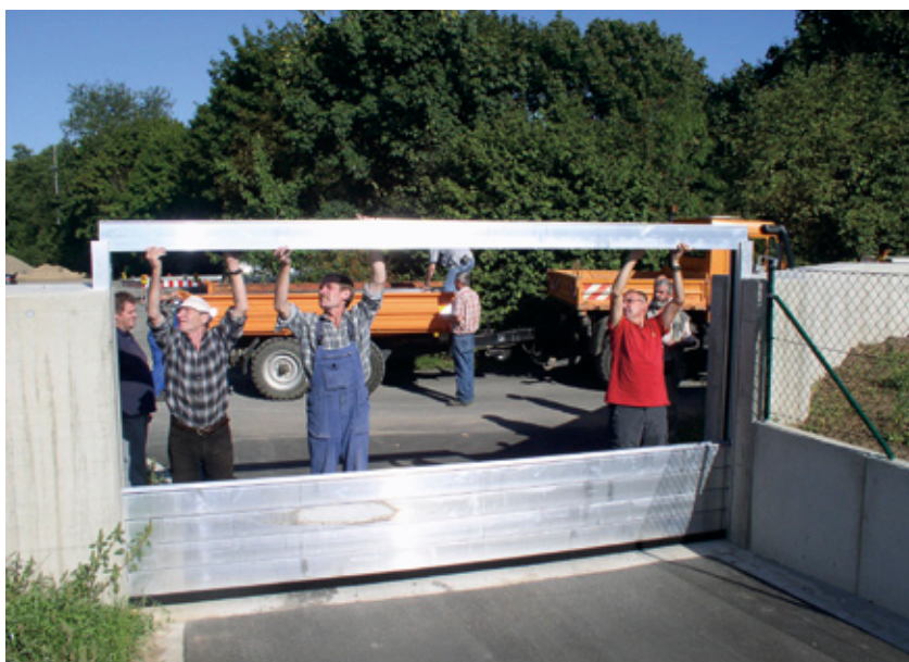
Mobile Schutzeinrichtung am Durchgang zum Vorland des Mains an der Johann-Wenzel-Straße in Sennfeld
