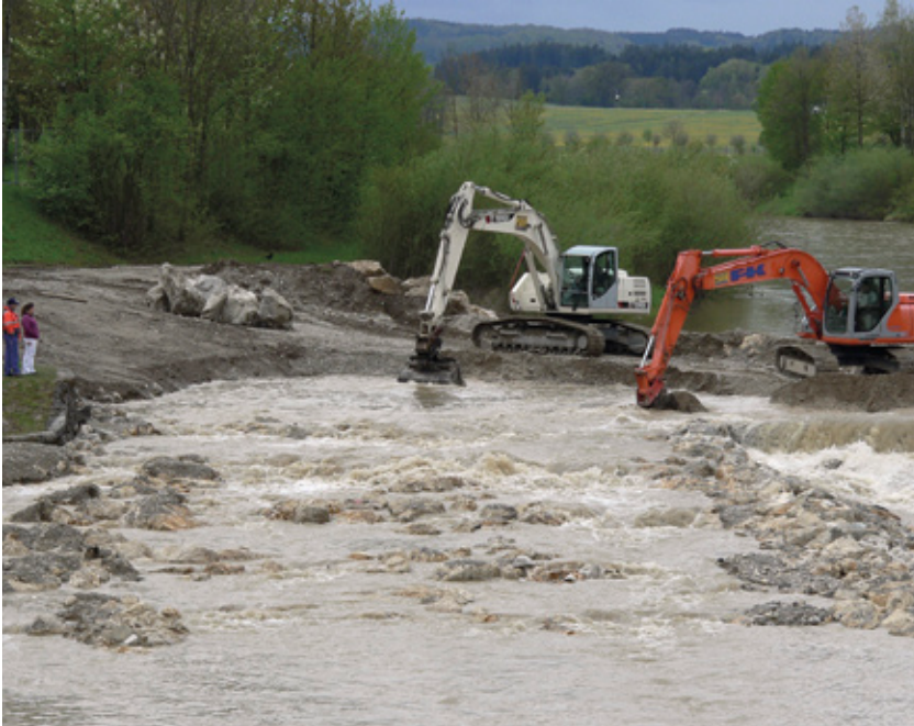
Öffnen des Fangedammes, die Teilrampe wird zum ersten Mal geflutet.
