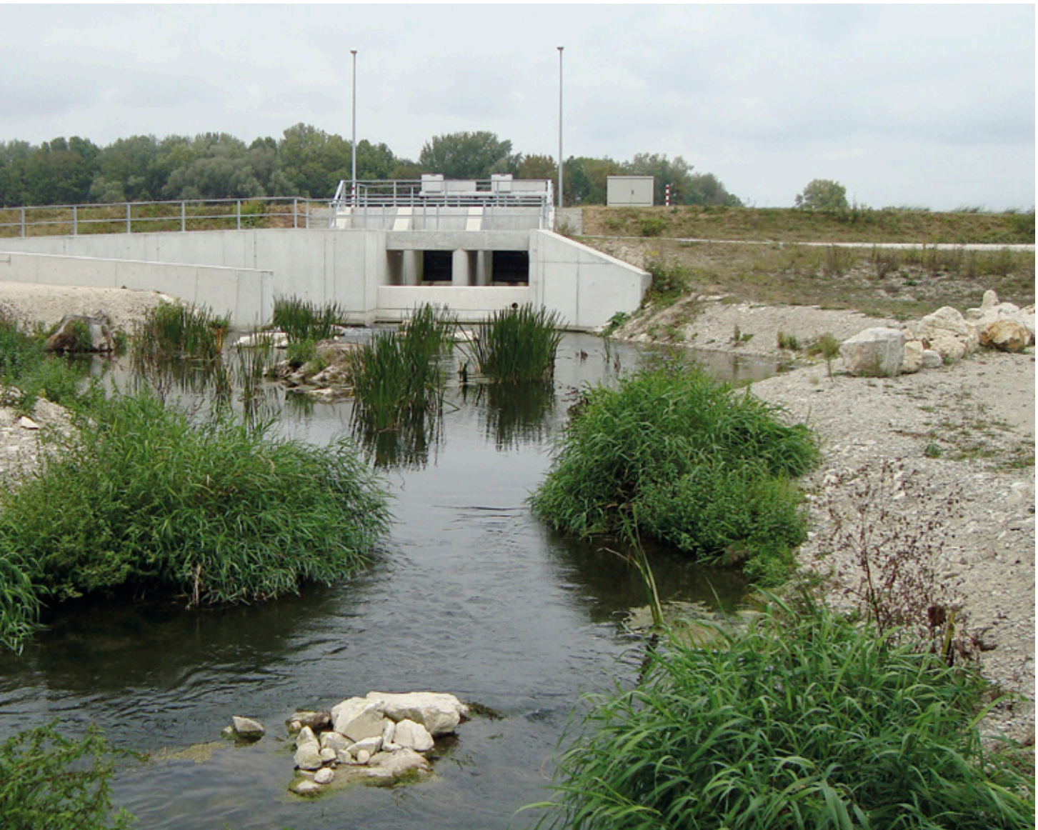
Neuer Umgebungsbach mit Ausleitungsbauwerk
