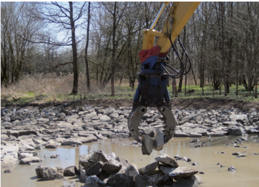
Bau eines Raugerinnes
