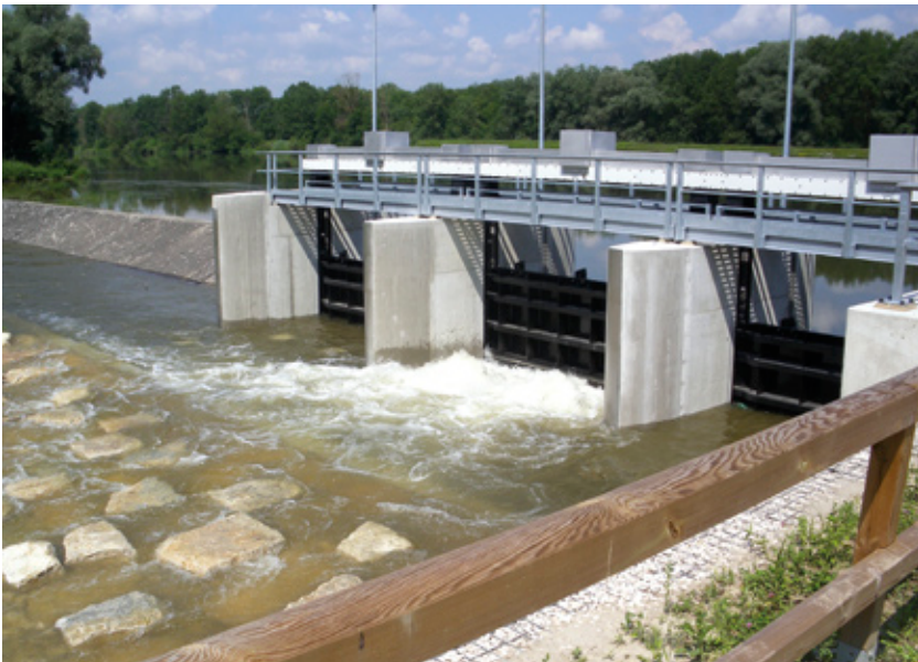
Ausleitungsbauwerk für die ökologischen Flutungen im Probebetrieb
