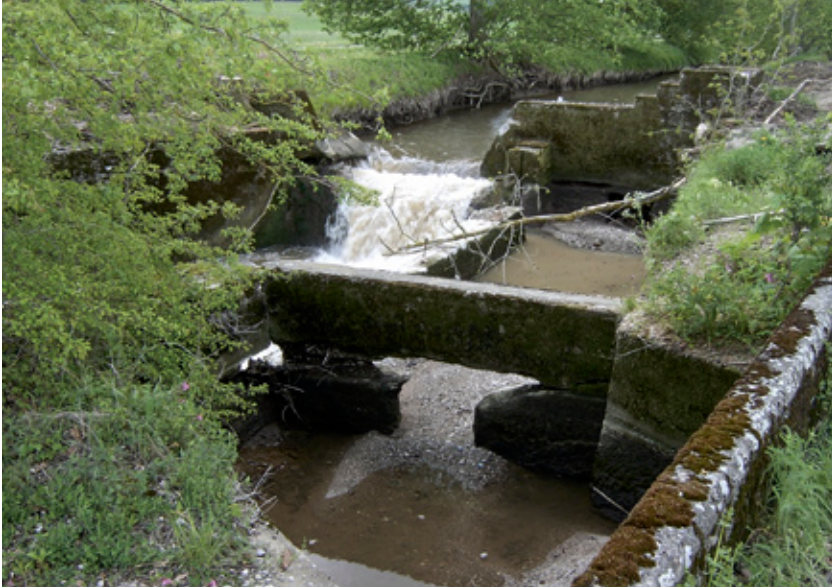
Typischer Gewässerabschnitt vor der Renaturierung – massiver Uferverbau mit Absturz und Ausleitungsbauwerk
