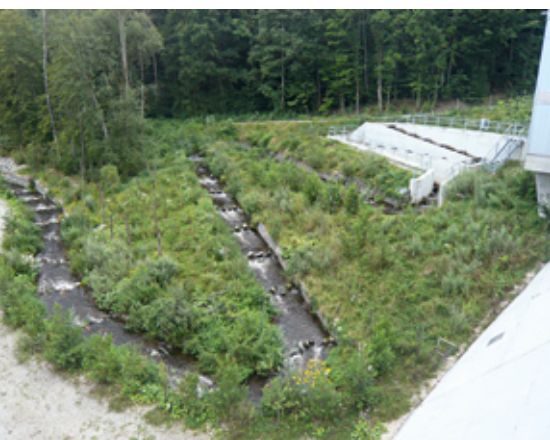
Umgehungsgewässer und technische Fischaufstiegsanlage an der Ilz (Foto: © C. Mayr LfU)
