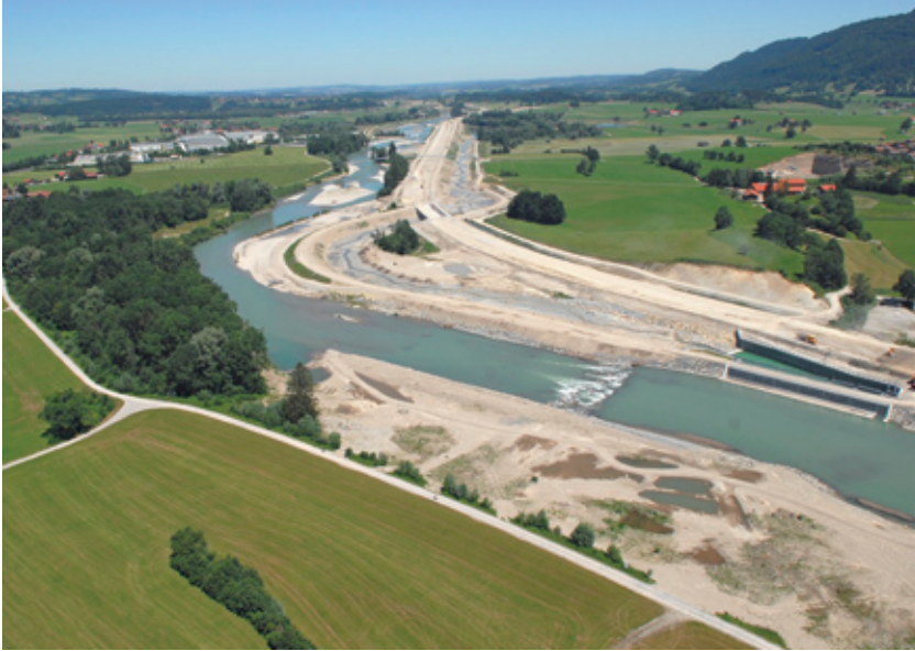
Einlassbauwerk mit Flutrinne in den Polder Weidachwiesen nach Fertigstellung 2007
