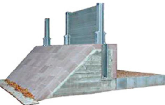
Miltenberg wird teilweise durch ein mobiles System vor extremen Hochwassern geschützt. Die feststehende Mauer schützt vor einem 25-jährlichen Hochwasser, wobei ein Freibord von 35 cm verbleibt, die mobilen Dammbalken und Stützen aus Stahl und Aluminium schützen vor einem 100-jährlichen Hochwasser, wobei 55 cm Freibord verbleiben.
