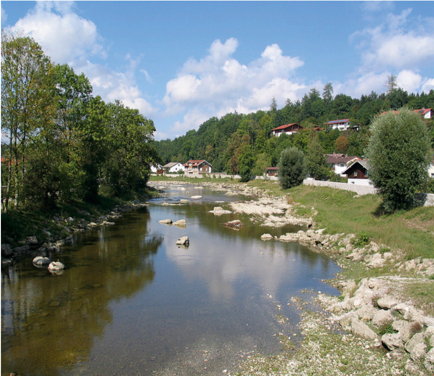
Fertiggestellter Abschnitt zwischen Gas- und Kammerer Brücke
