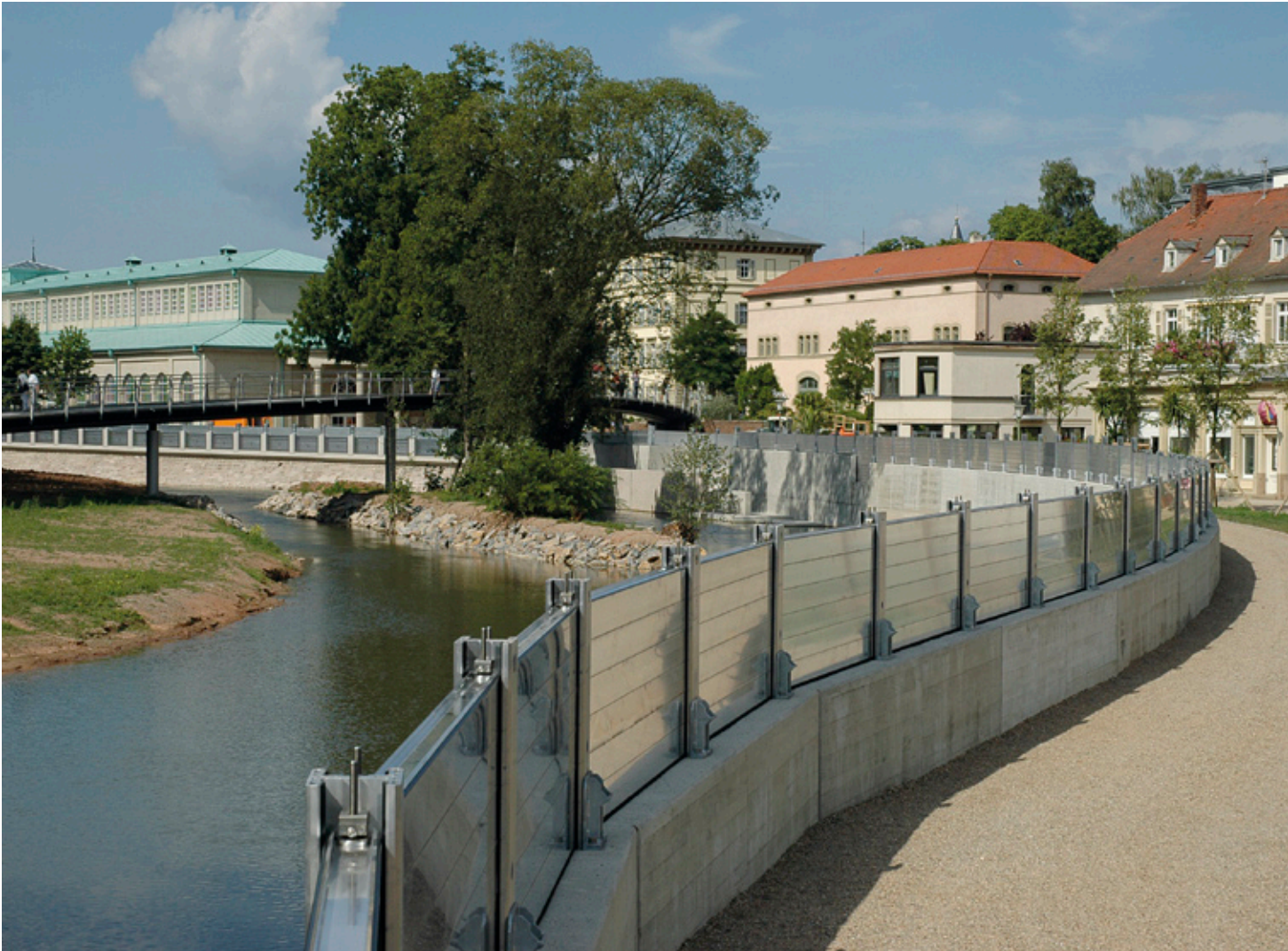
Schutzsystem mit aufgebauten mobilen Elementen an der Lindesmühlpromenade
