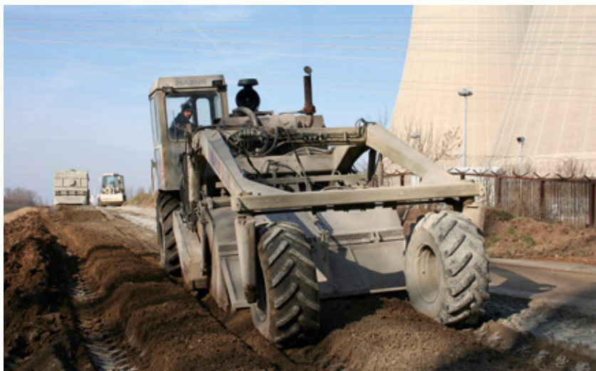
Deichsanierungsarbeiten unmittelbar am AKW Grafenrheinfeld
