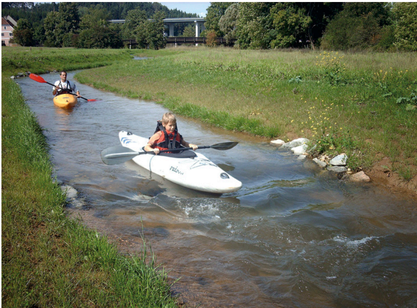
Das Umgehungsgewässer mit einer Wasserführung von 900 l/s kann auch gut mit Booten befahren werden.
