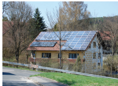
Energetische Sanierung im Quartier
